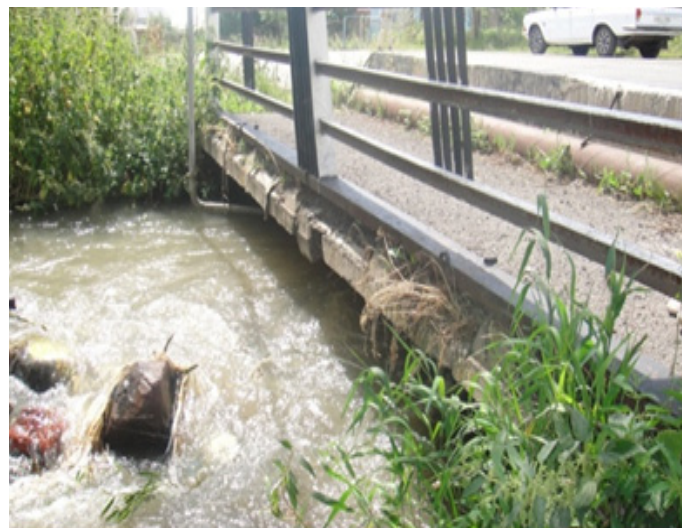
ԽԿԳ ընթացքում բացահայտված խնդիր: Շիրակի համայնքի գետի հունը բարձրացել է, և տեղումների ժամանակ ջուրը հոսում է կամուրջը վրայով՝ անանցանելի դարձնելով ճանապարհը:
