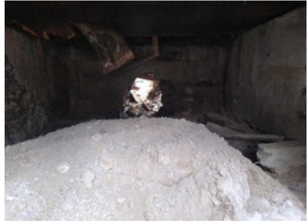
ՆԿԱՐ 7. Անցք, որի միջով ջուրը թափանցել է Քարկոփ գյուղ
