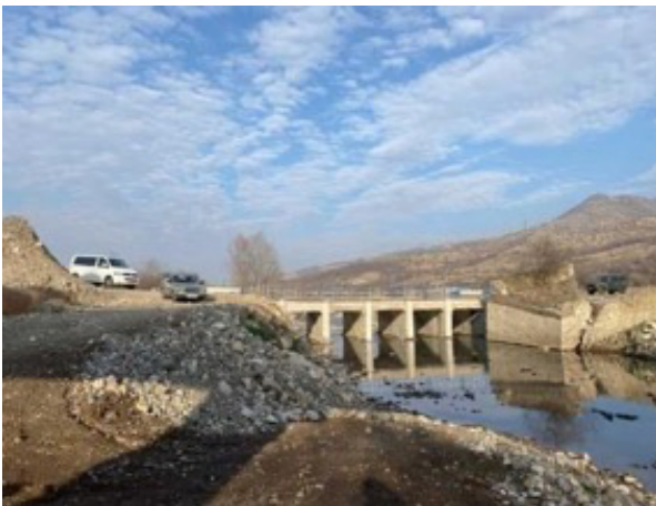
ՆԿԱՐ 18. Ողողաքանդված կողային պաշտպանական կառույցներ
