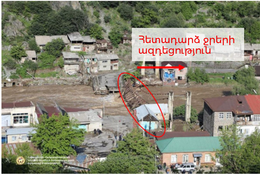
ՆԿԱՐ 34. Վնասված կամրջի հետևանքով առաջացած հետադարձ ջրերի ազդեցությունն Սանահին կայարանում
