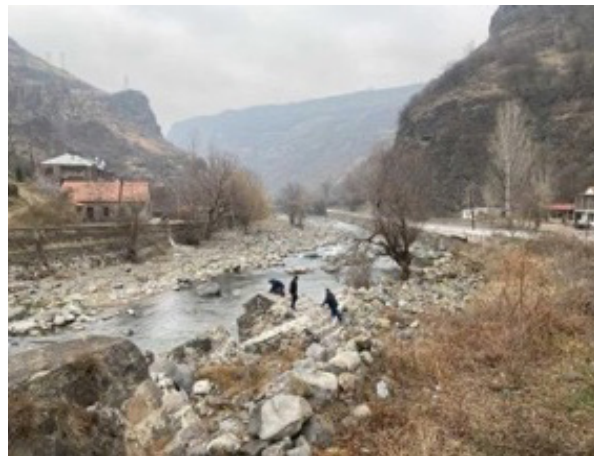
ՆԿԱՐ 19. Ավերված ափապաշտպան կառույցներ՝ Փամբակ և Ձորագետ գետերի միախառնման ստորին հատվածում
