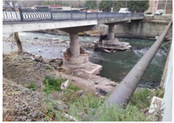
ՆԿԱՐ 13. Ալավերդիի կամրջի հիմնասյուների ողողաքանդում
