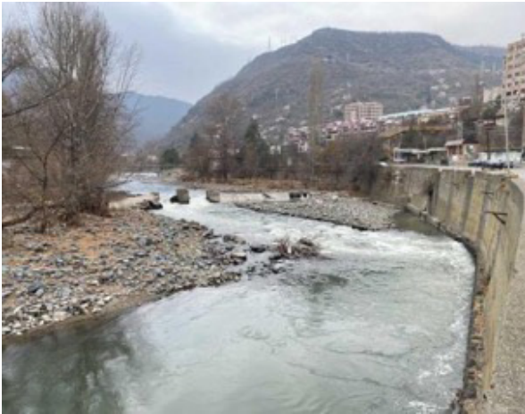
ՆԿԱՐ 25. Զուրը դեպի պաշտպանիչ պատ ուղղորդող ամբարտակի մնացորդներ
