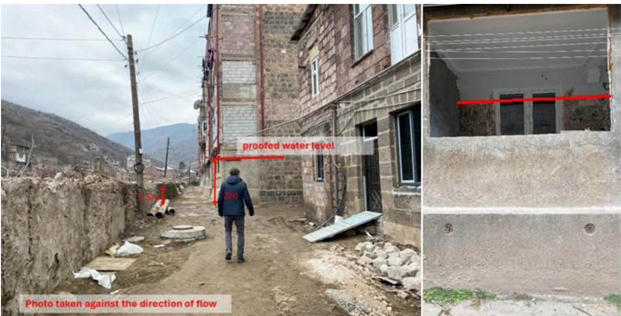
ՆԿԱՐ 33. Պաշտպանիչ պատի և վնասների բարձրությունը / ջրի հաստատված մակարդակը՝ Սանահին կայարանի հատվածում Դեբեդ գետի արևմտյան ափի ճանապարհի համեմատ
