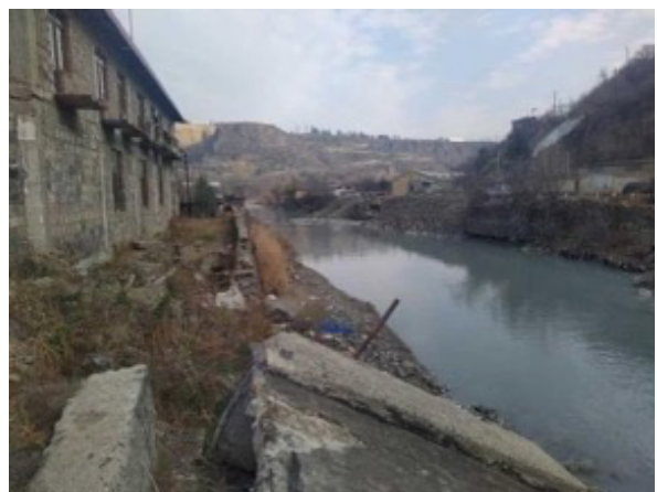
ՆԿԱՐ 21. Դեբեդ գետի աջ ափին գտնվող ավերված ափապաշտպան կառույցներ՝ Զարկոփում
