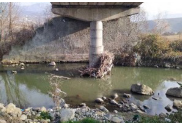
ՆԿԱՐ 10. Խաչթառակի կամուրջը կողային պատի ողողաքանդմամբ
