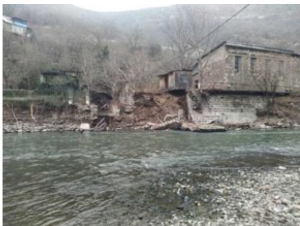
ՆԿԱՐ 20. Դեբեդ գետը Սանահինում ավերված ափապաշտպան կառույցներով
