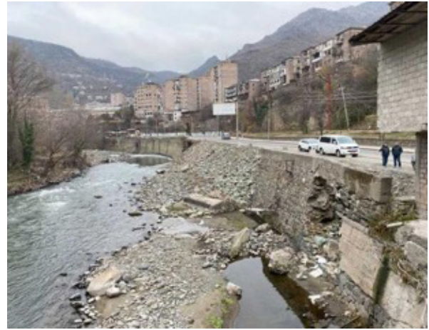
ՆԿԱՐ 26. Պաշտպանիչ պատի փլուզում՝ ամբարտակից հոսանքով ներքև
